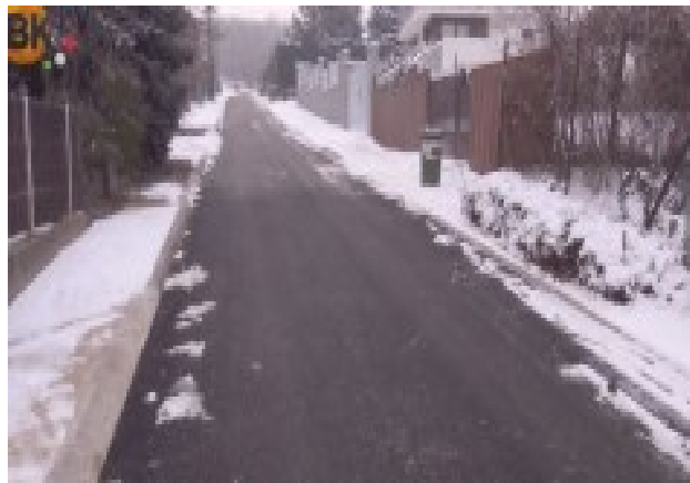
2. ábra – a Zengő utca aszfaltozása
